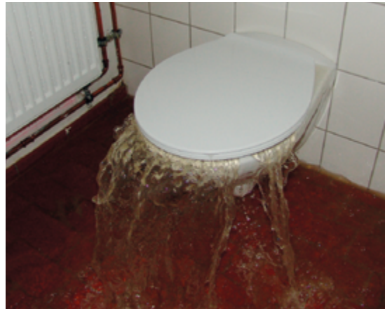
Abb.21: Überlaufende Toilette durch Kanalrückstau
