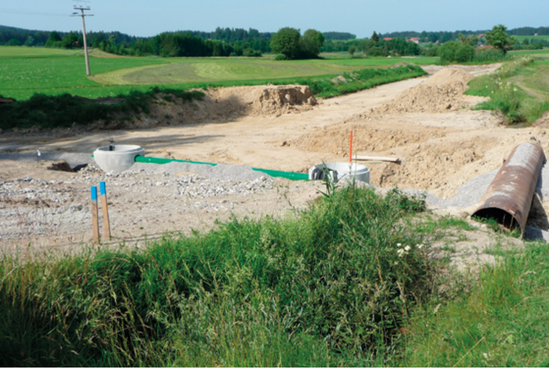
Abb. 67: Bau einer Dorfbachumleitung in der Gemeinde Bernbeuren in Oberbayern
