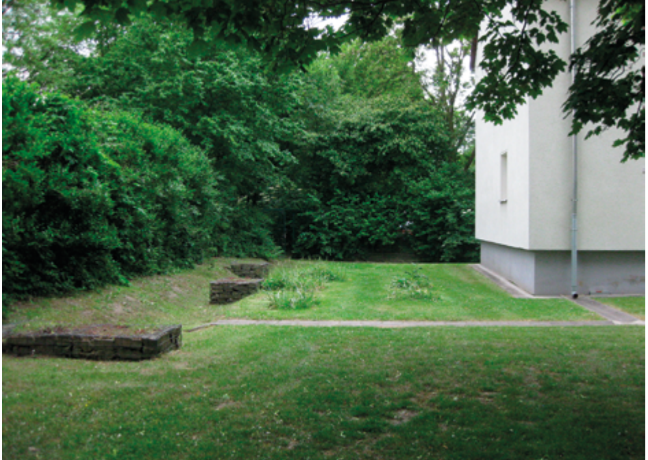
Abb. 93: Gartenanlage mit offenem Regenabfluss und Sickermulde
