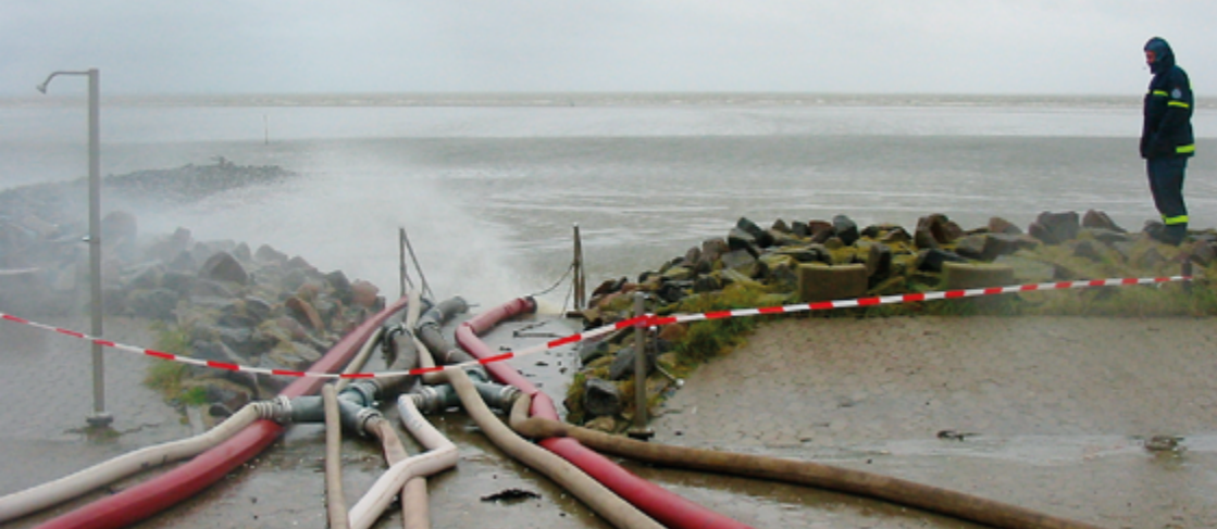
Abb. 81: Auch der richtige Umgang mit Wasserpumpen will gelernt sein.
