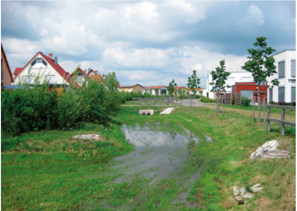
Abb. 70: Überflutungsmulde in Erlangen in einem Wohngebiet
