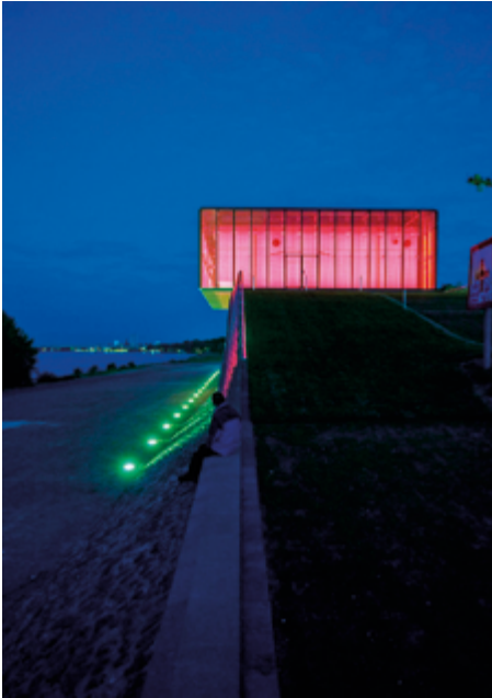
Abb. 60: Das Pumpwerk in Köln bei Nacht mit weithin sichtbarer Lichtinstallation
