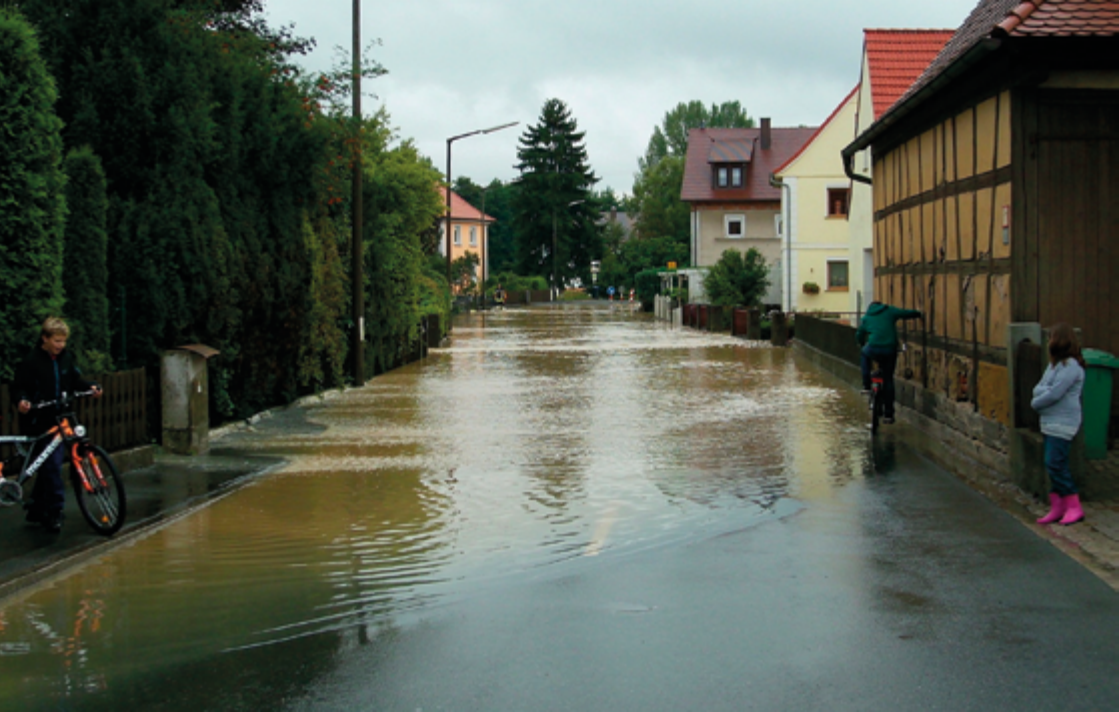
Abb. 18: Überflutete Straße nach Starkregen
