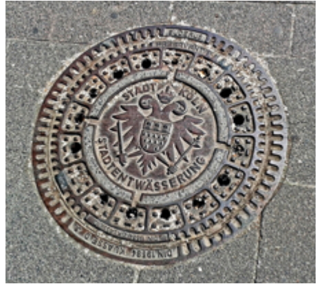
Abb. 30: Kanaldeckel der Stadt Köln
