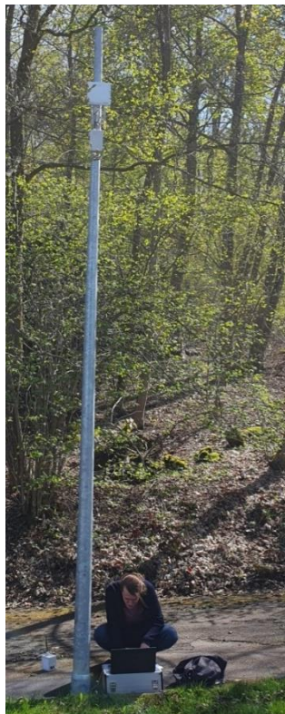
Abbildung 15: Montierter Mast mit Funkmodul bei der Einrichtung
